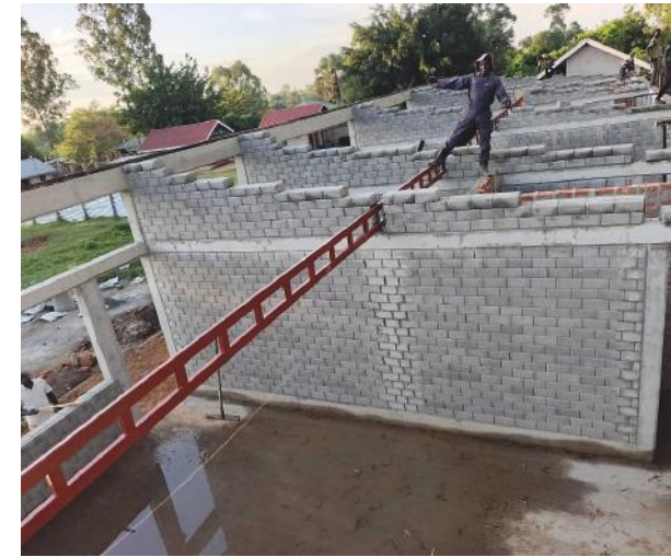
Baustand Primarschule Lira: Oktober 2024
